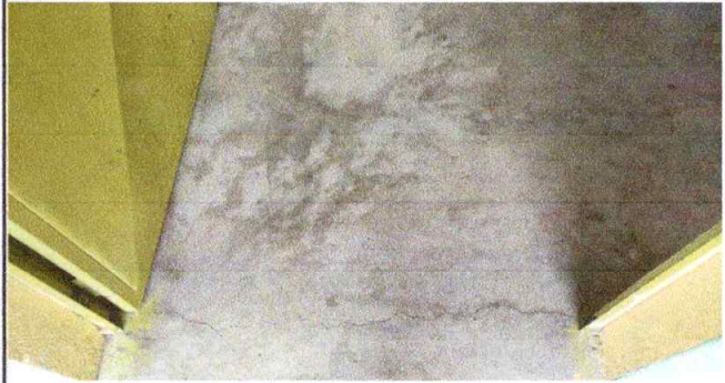
Foto 2: Sustrucción de piso aula de primero y segundo por piso cerámico
