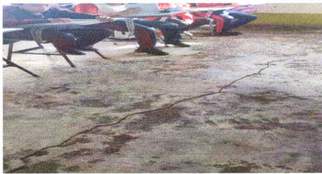
Foto 1: Sustrucción de piso aula de cuarto y quinto por piso cerámico
