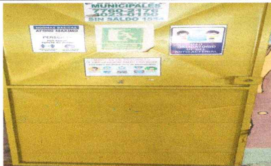
Foto 5: Cambio de Chapa de puerta de aula
